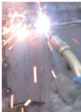
第三步：连续焊接焊缝接口
