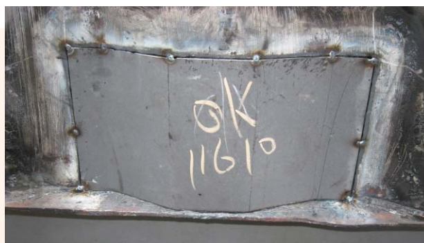
第二步：安装替换件并点焊，检查装配质量
