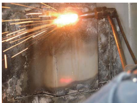
第一步：气割切除受损部位
