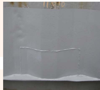
第五步：打磨、油底漆和面漆
